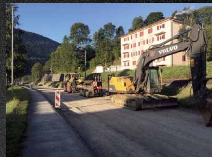
GÉNIE CIVIL / TERRASSEMENT
